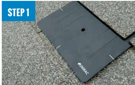
INSTALL FLASHKIT PRO FLASHING
