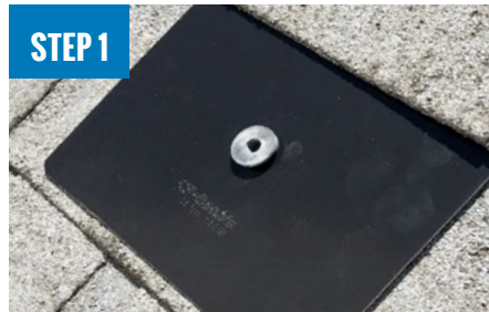
INSTALL FLASHKIT PRO FLASHING
