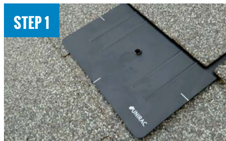
INSTALL FLASHKIT PRO FLASHING
