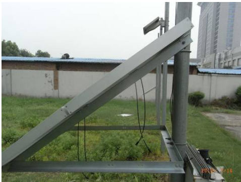
安装好的组件和支架
